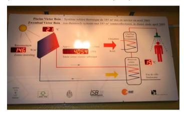
La Puissance instantanée du rayonnement solaire est de 146 Watt par m². En dépit du faible ensoleillement mesuré, la température du fluide à la sortie du champ de capteur atteint 21°C alors que la température de l'eau dans réservoir de stockage est de 15°C. Une différence de 6°C suffit à enclencher la pompe solaire et à préchauffer l'eau sanitaire.
